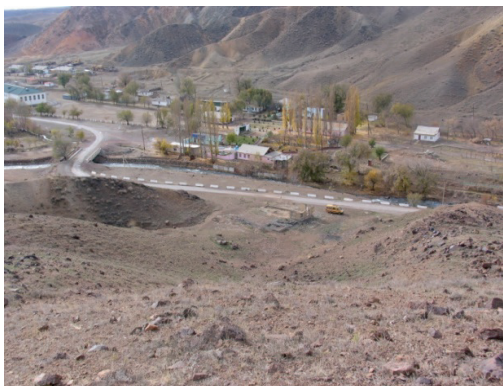
Рисунок 1. – Оползневый участок (вид сверху)
