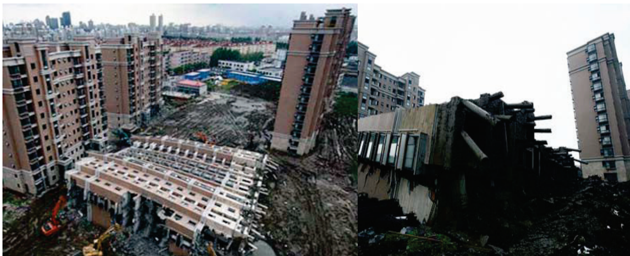
Рисунок 3. - Деформации оснований зданий, расположенных на склоне
