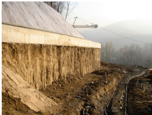
Рис.1. - Общий вид подпорной стенки из буронабивных свай диаметром 1.0 м
