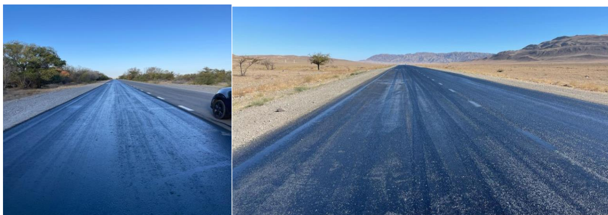
Рисунок 3. Применение пропитывающего омолаживающего состава «Реджувасил » Rejuvaseal в рамках среднего ремонта
