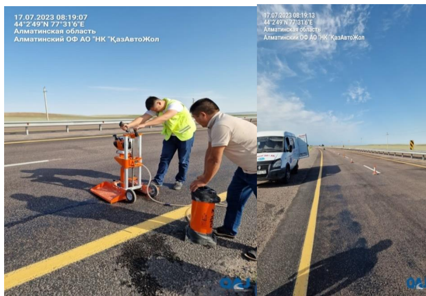
Рисунок 4. - Отбор кернов на участке среднего ремонта.
