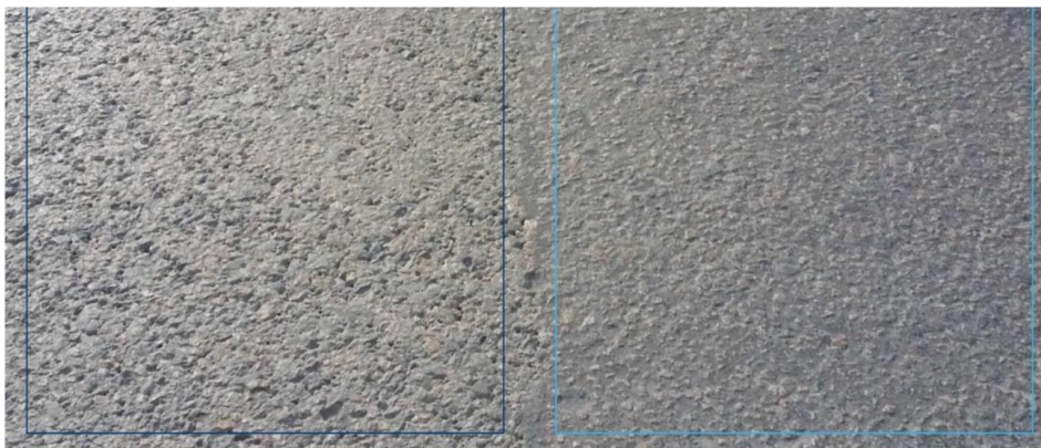
Рисунок 1. - Асфальтобетонное покрытие без применения пропитки (слева) и с применением пропитки (справа)
