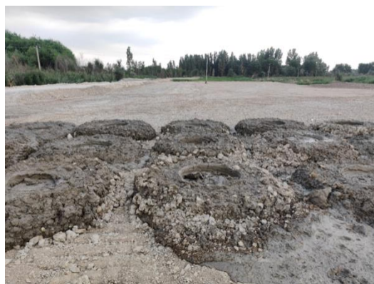
Рисунок 6 – Готовые грунтоцементные колонны после производства работ
