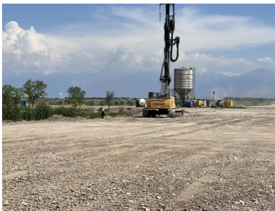
Рисунок 4 – Готовая площадка для работы по устройству грунтоцементных свай
