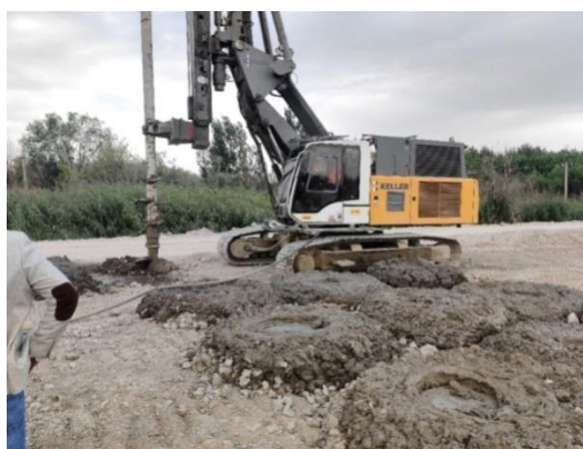
Рисунок 5 – Процесс бурения грунтоцементных колонны
