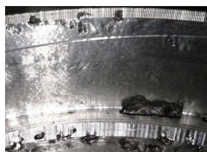
Фотография скрытых дефектов в сварных швах труб большой толщины стенки
