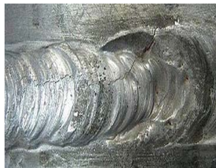
Фотография разветвленной трещины сварного шва, уходящая в глубину
