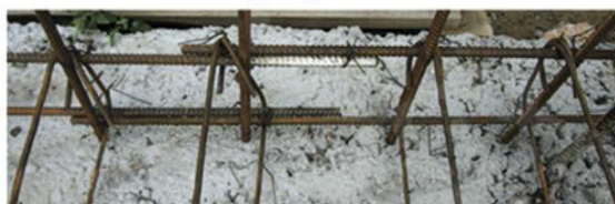
Рисунок 1. Соединение арматуры внахлест методом связки
