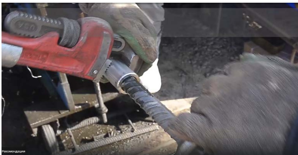
Рисунок 4. Монтаж арматуры методом механического соединения (муфта)
