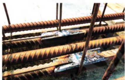
Рисунок 2. Соединение арматуры методом сварки
